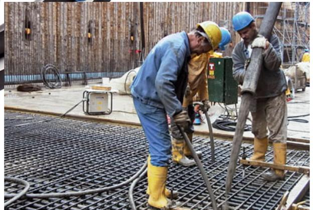
**IV-Hochfrequenz-Innenvibratoren sind Komplettgeräte mit eingebautem Motor für die professionelle Betonverdichtung.**
